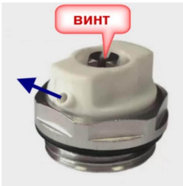
Осмотреть батарею и найти небольшой клапан (кран Маевского). Установить его в верхней части радиатора с торцевой стороны. Подставить под место расположения клапана емкость для сбора воды.
