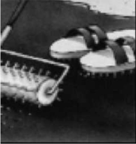
Рисунок 26. Распределение смеси игольчатым валиком.
